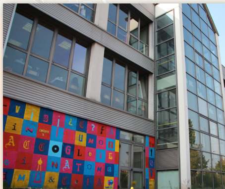
Istituto lato Nord, Via Michelangelo
